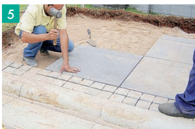
5 Execução de cortes, ajustes e alinhamento.
