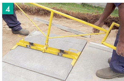
4 Colocação das placas de concreto com saca-placas.
