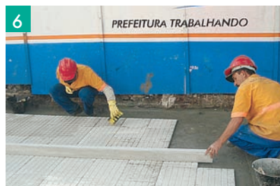
6 Conferência de nível, aplicação de argamassa de rejuntamento, limpeza e abertura ao tráfego.
