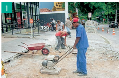
1 Nivelamento e compactação do subleito (terreno).
