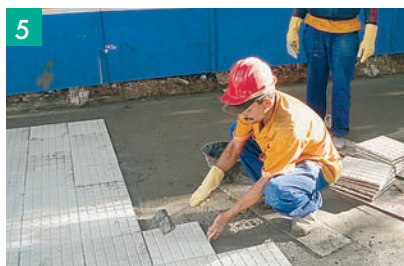
5 Assentamento das placas.
