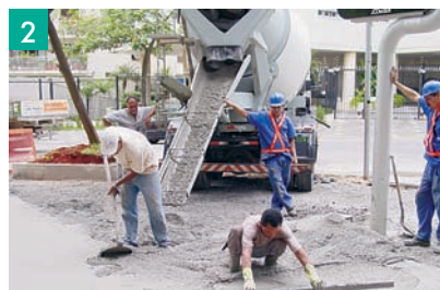
2 Lançamento, espalhamento e nivelamento (sarrafeamento) do concreto.
