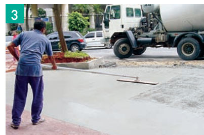
3 Desempeno do concreto (para acabamento convencional: desempenar, executar juntas e curar).
