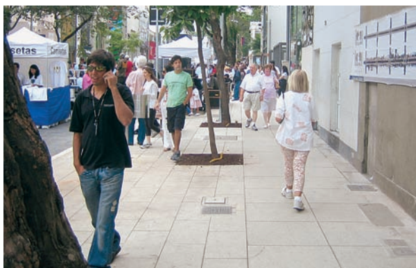
Rua Oscar Freire/SP – Placas de concreto.
