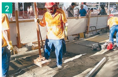
2 Aplicação e adensamento da argamassa de assentamento tradicional (ou argamassa colante).
