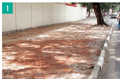
1 Nivelamento e compactação do subleito (terreno).
